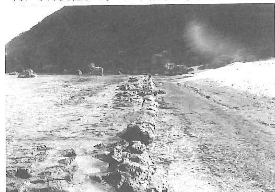
写真10 城辺地区 吉野海岸 多量の採砂によって露出したチーロックで沈砂 している部分と汀線部の崩壊部分が見える。
